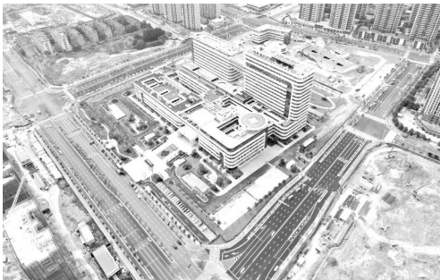
医院周边道路全部竣工
