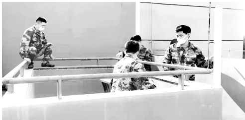
对违建实施拆除 执法人员 在楼顶
