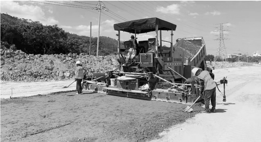
路面水稳层正在摊铺
