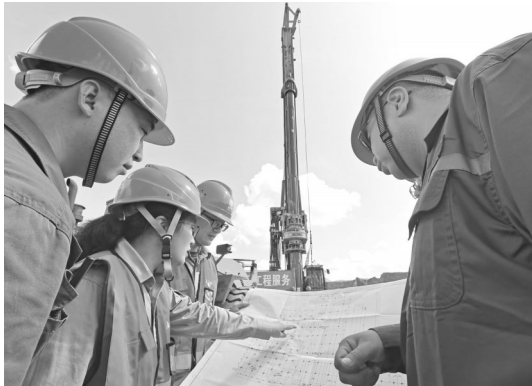
闽粤联网工程广东侧滤波场桩基施工打下第一根桩,标志着该工程正式进入现场施工阶段
