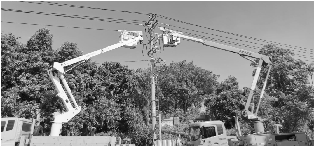
工人正在进行线路检修维护
