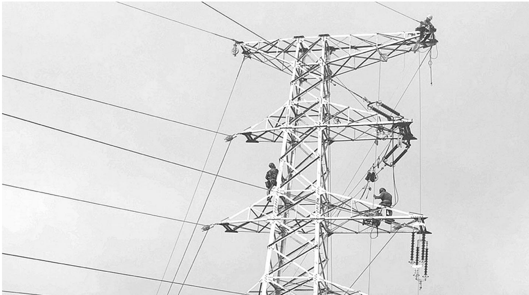
电力工人在高空铁塔上作业
