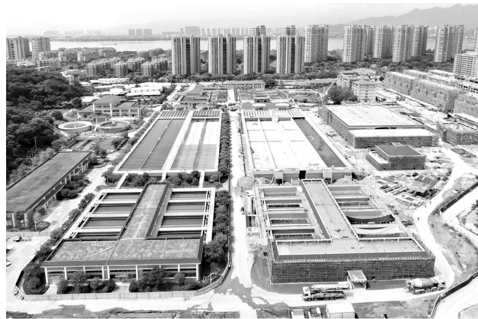
福州飞凤山供水厂扩建规模15万吨/日的常规处理工艺,新建规模30万吨/日的深度处理工艺,工程将于年底全部完工并投入生产试运行(包华/图)
