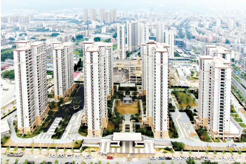
凤翔佳园小区建设8栋高楼
