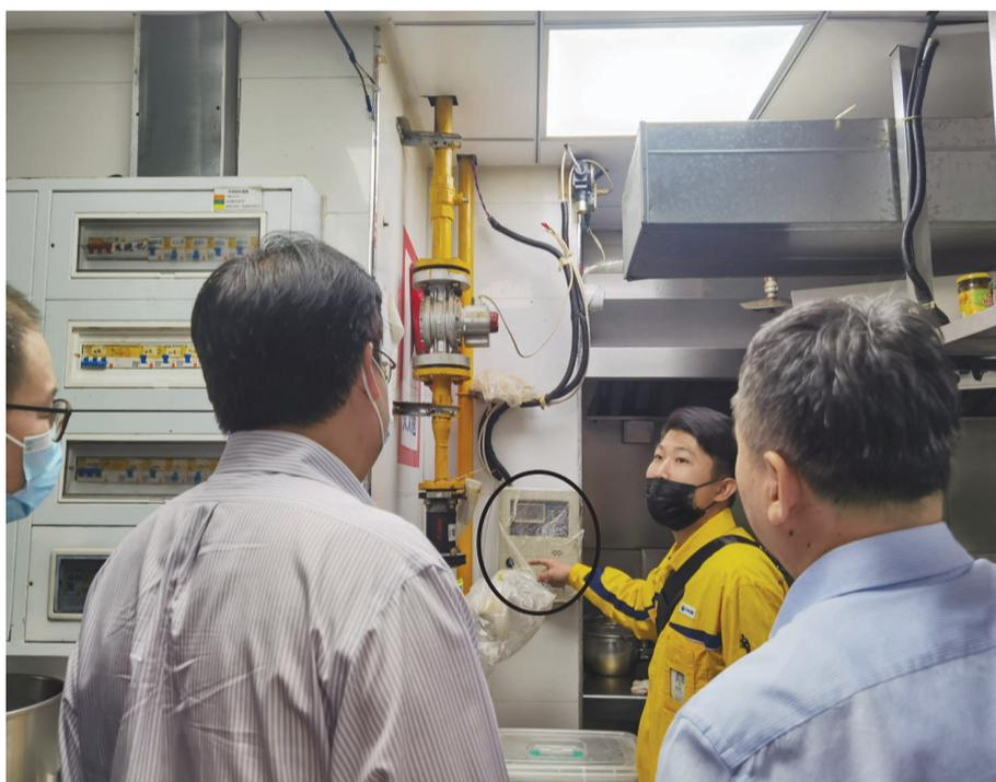
燃气安全员讲解可燃气体报警装置工作原理(画圈处为报警器主机)
