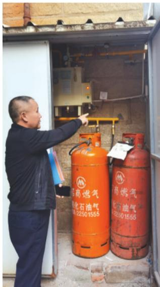
这套报警装置设在厨房外,还隔着墙,安装不规范
