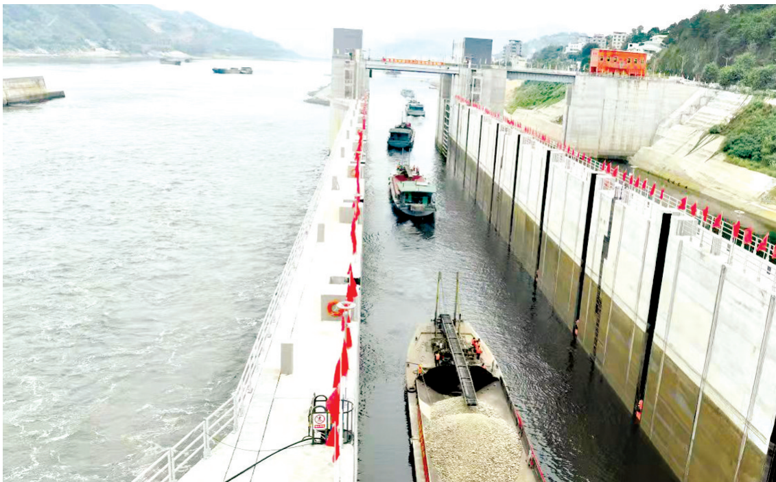
多艘船舶依次平稳通过船闸人字门并经过宽阔的下游引航道进入闽江航道
