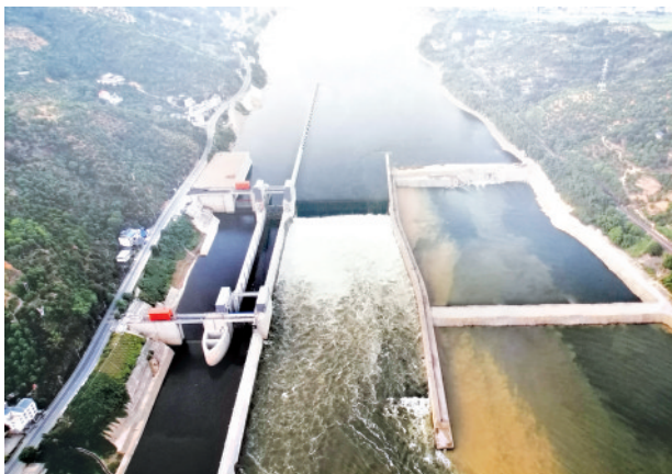
闽江水口坝下工程全景
