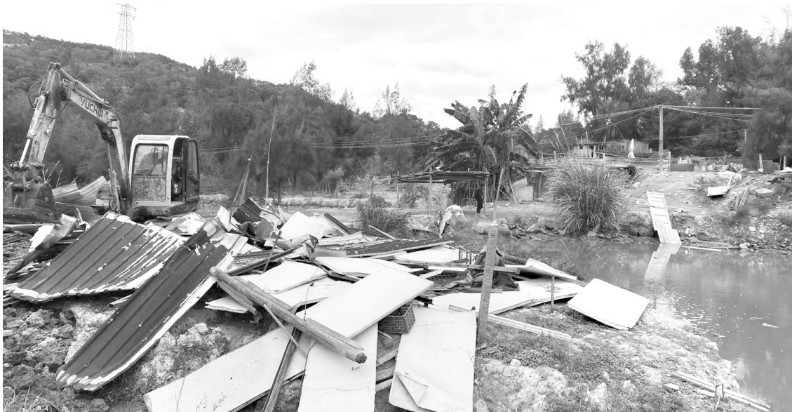
违建养鸭场被拆除
