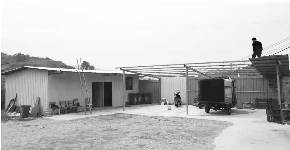
拆除长沙园违章建筑
