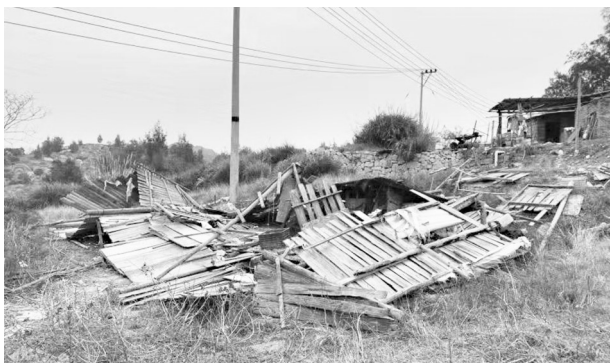
一违建养殖场被拆除
