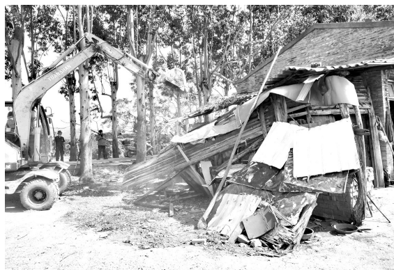
拆除琅岐镇桉树大道附近一处违建
