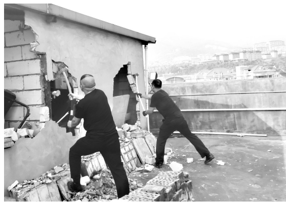
拆除罗星街道立马花园一处顶楼违建
