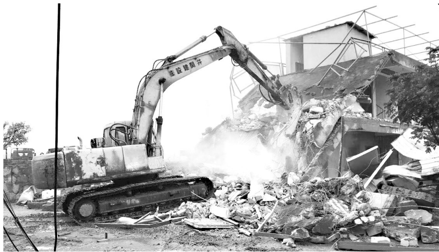
拆除琅岐镇金沙一处违建
