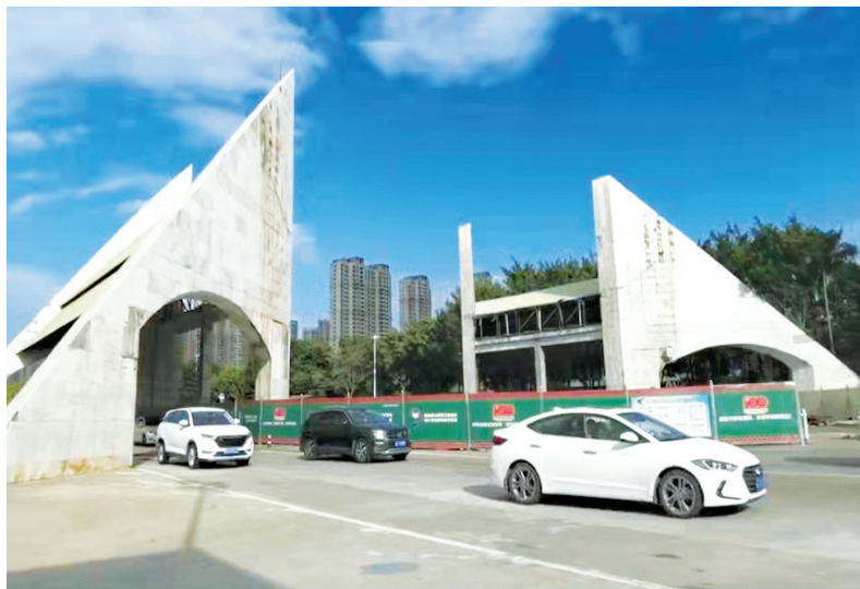
正在施工的刺桐大桥旧收费站
