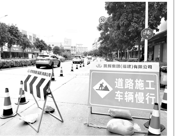
原有路面为水泥路,改造工程已经开始
