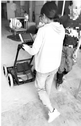
暗管探测仪探测厂区内管线 (部门供图)
