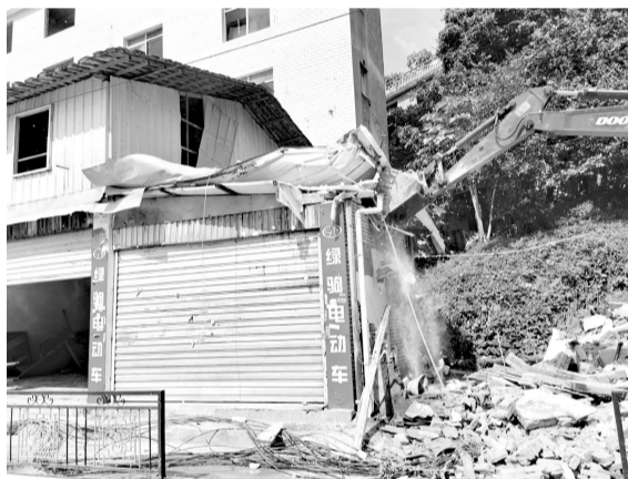
拆除南屿镇一处违章建筑
