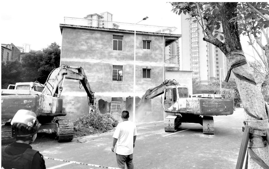
拆除村镇办一处违章建筑
