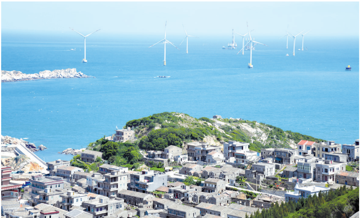
福建省平潭综合实验区大练海域海上风电场
