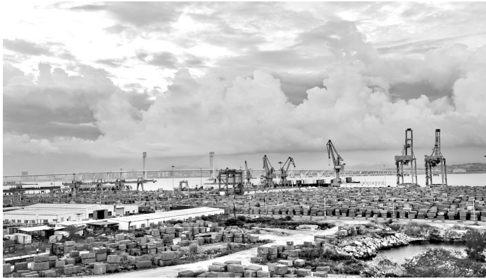
泉州重点建设的石湖港码头
