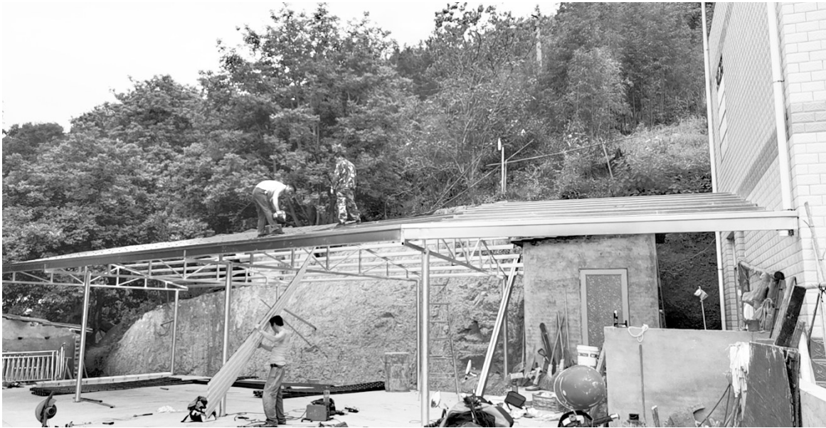
拆除占地违规搭建停车棚
