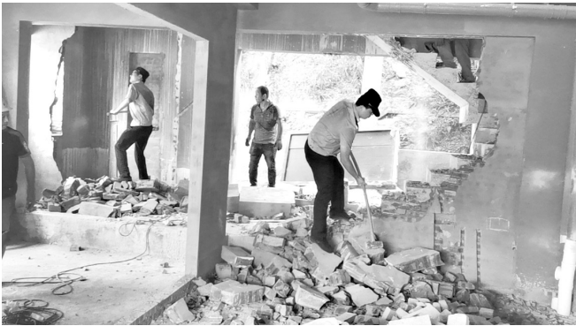
拆除架空结构层违法改建
