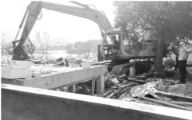
拆除小区挤占绿地违法建设一层框架结构
