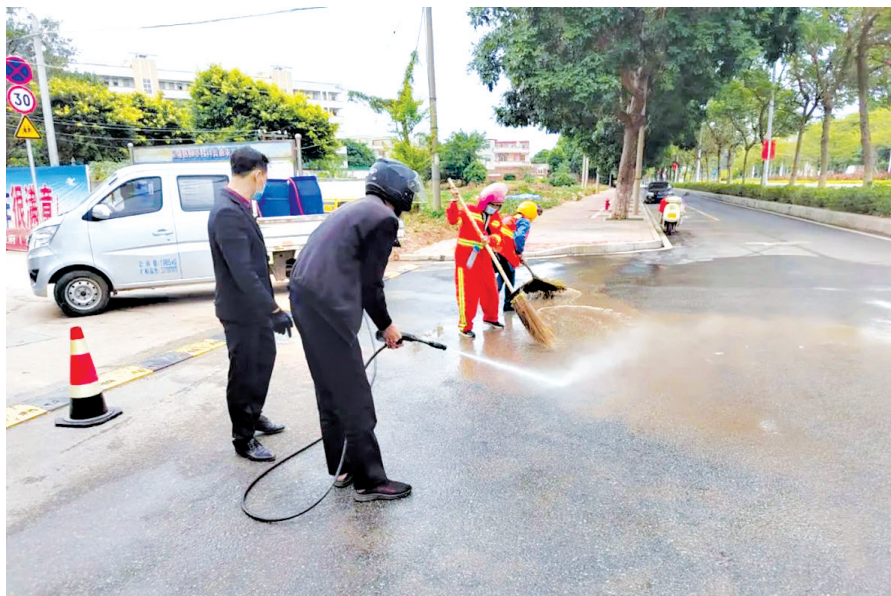
集中整治,驿峰东路路面浮土得到改善
