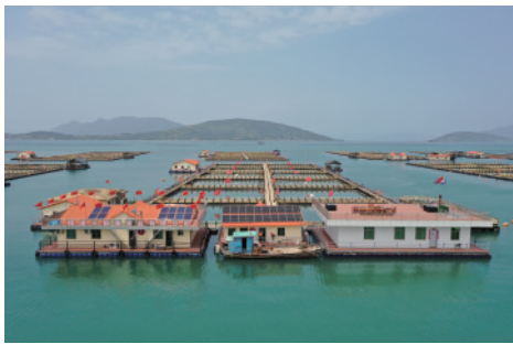
建设首个海上渔排风光储微电网，打造“福建典范”。
