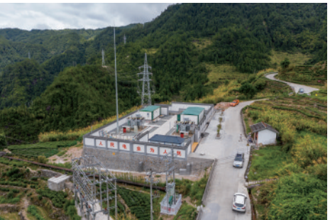
2020年，提前一年投产35千伏下党变电站，提升下党乡供电可靠性。
