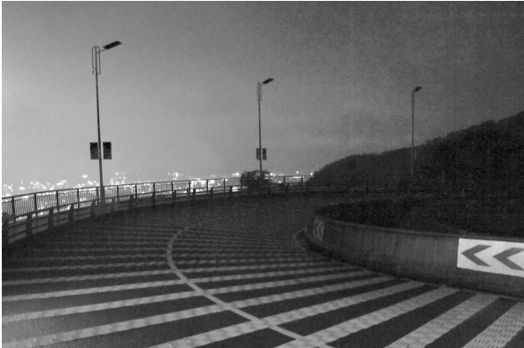
盘山公路弯道多,若没有路灯照明存在安全隐患
