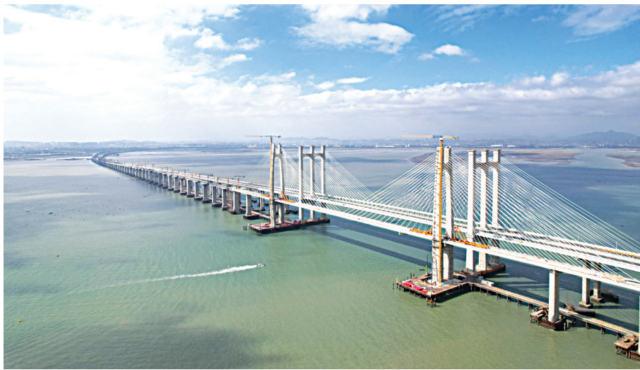
福厦高铁泉州湾跨海大桥全桥贯通。胡晓虎/摄
