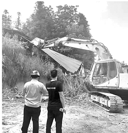
塔庄镇政府组织拆除违建龙窑
