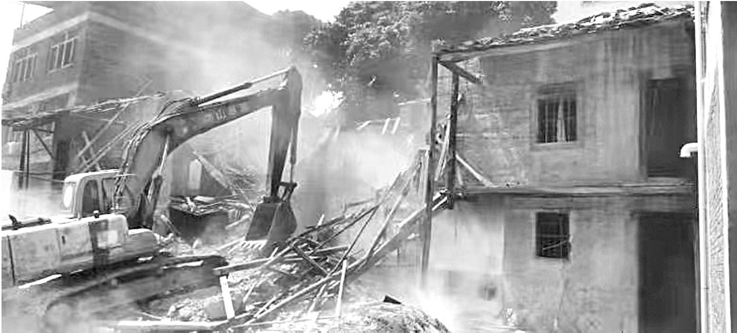
一违建房屋被当场拆除
