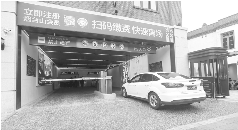
烟台山商业街地下停车场入口处，未设置车位信息告知系统
