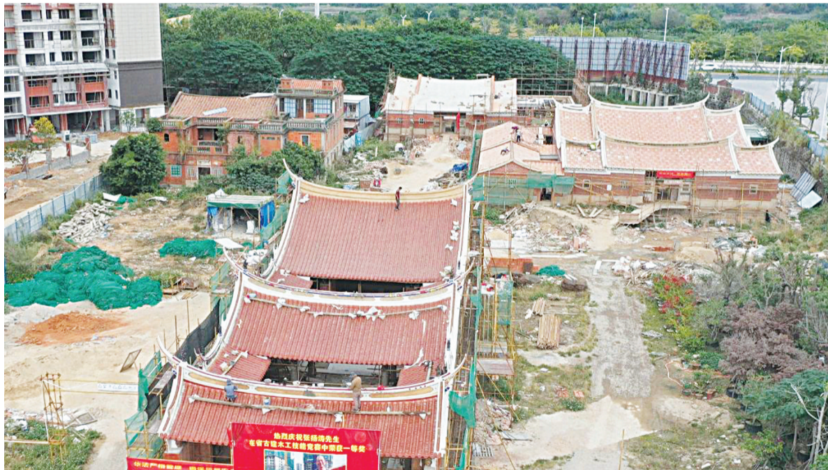
迁移后,4栋建筑在一个区域内,前方为龙溪祖祠,左后方为特色民居
