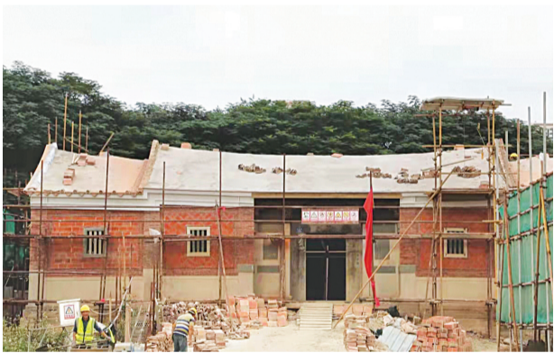
这栋建筑的屋顶将翻修,保持风格统一
