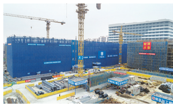
妈祖重离子医院项目现场
