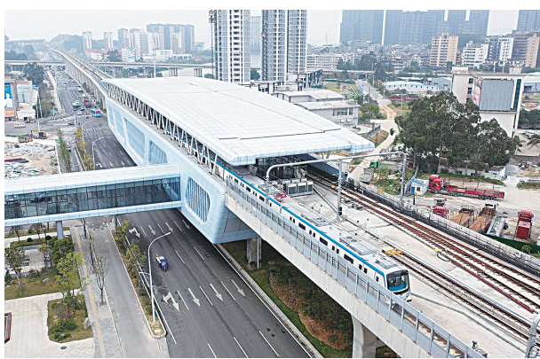
6号线地铁驶过营前站
