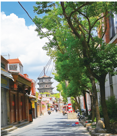
电线杆拆除前,巷子上方杂乱无章
