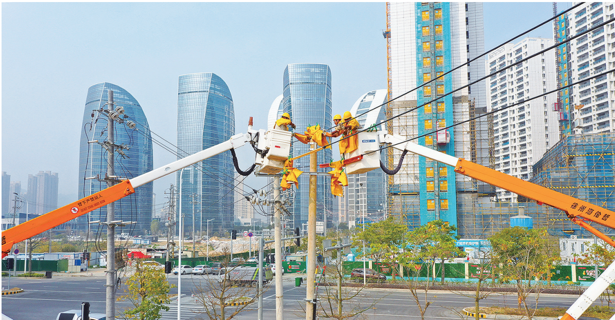
国网福州供电公司配电不停电作业人员带电进行配网线路升级改造
