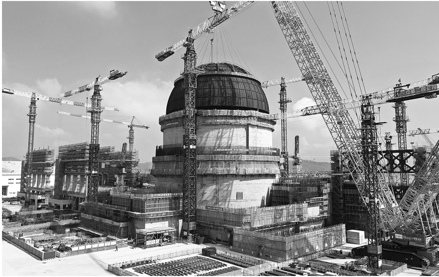
漳州核电2号机组穹顶吊装(福建日报/图)
