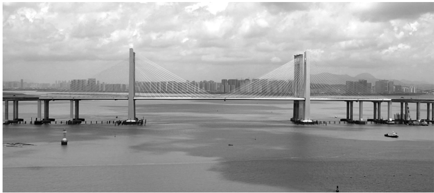
泉州湾跨海大桥
