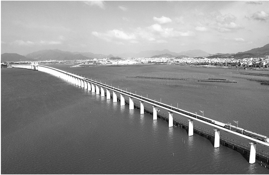
新建福厦铁路湄洲湾跨海大桥(新华社/图)
