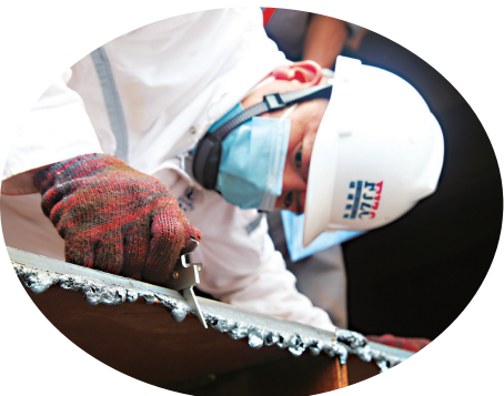
郭立勇正在对焊接坡口斜度进行检查
