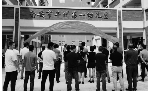
南安市丰州第一幼儿园(侨中路园区)建成揭牌
