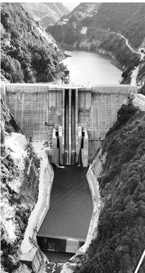
108米高碾压混凝土重力坝
