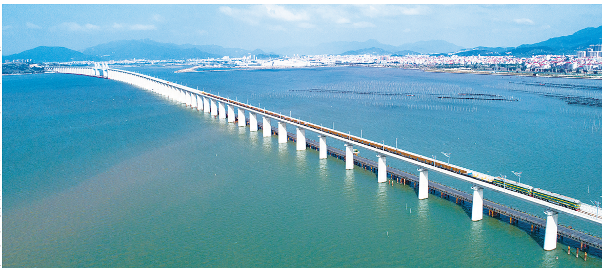
新建福厦铁路湄洲湾跨海大桥(新华社图)
