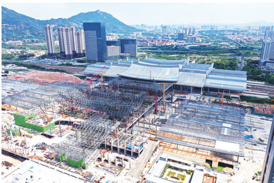
新建厦门北站建设现场
