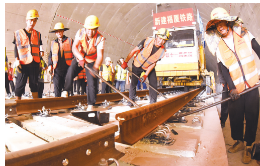
昨日,福厦高铁全线铺轨贯通
