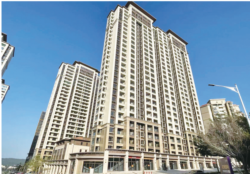
洛江刺桐春晓保障性租赁住房项目,共计二百六十套,目前主体工程已完工
