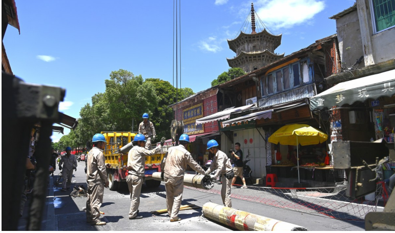
电杆拆除后,看东塔别有一番景致
