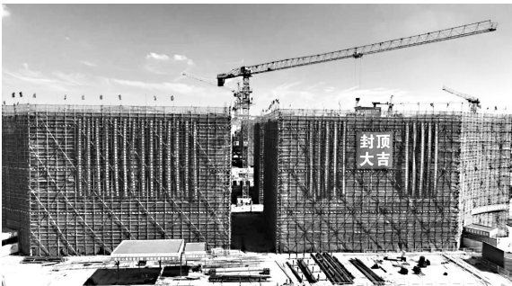
首批10栋厂房主体结构封顶
