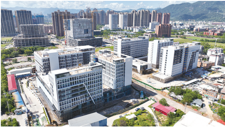
闽都创新实验室项目大楼
