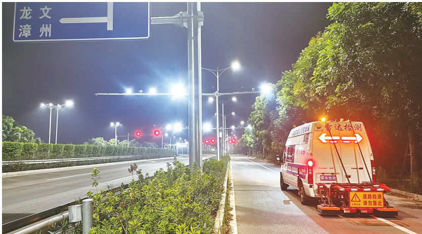
车载雷达对道路进行无损检测
