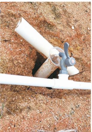
将微生物通过浸矿管道“注射”到矿山中,吸收水体中的氨氮
