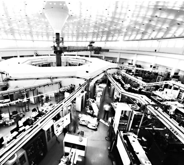
合肥同步辐射光源大科学装置
