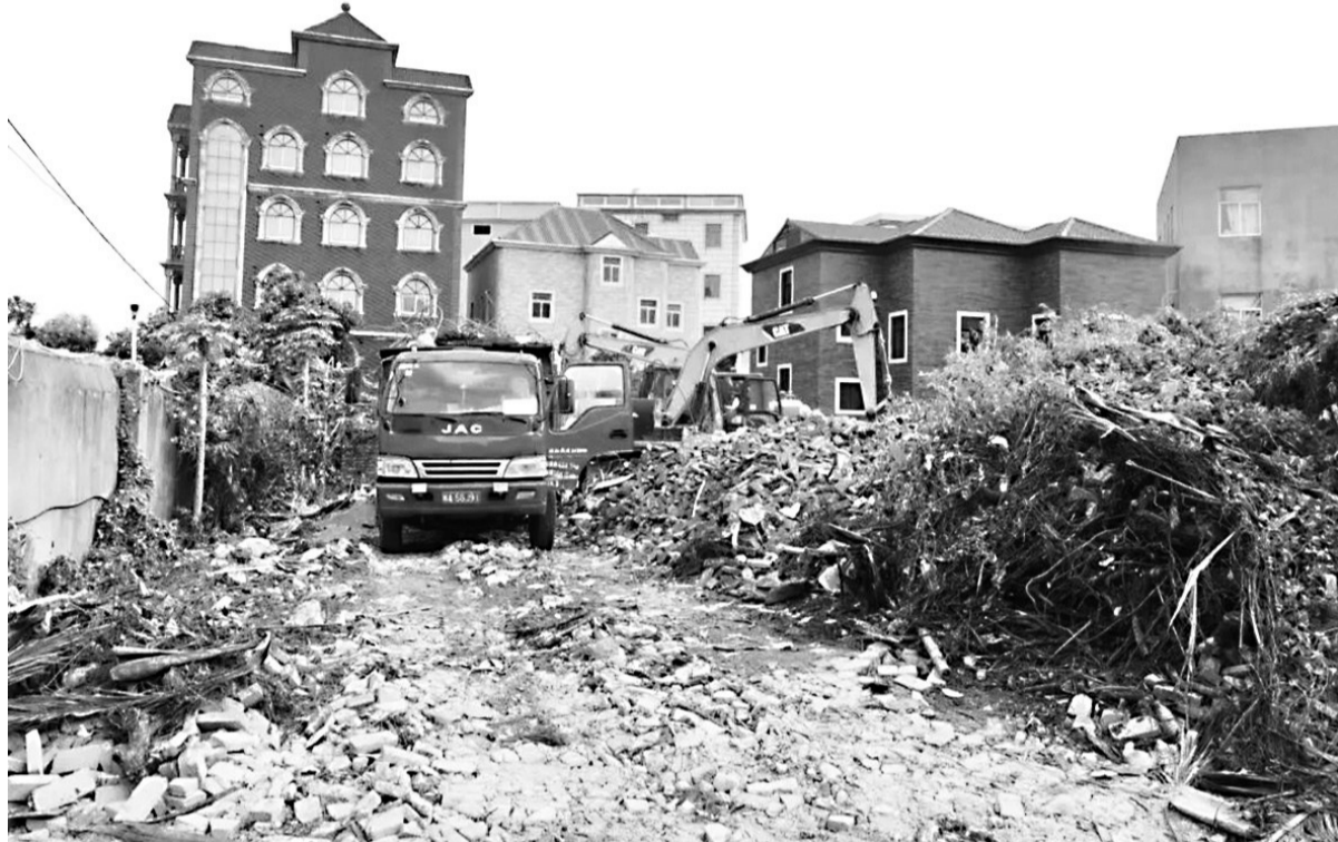
拆除港头镇东元村一栋违建房
