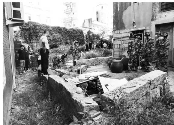
拆除违法建筑物
