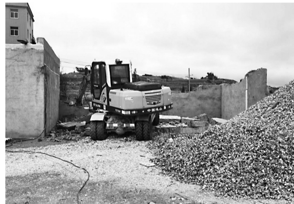
三山镇北陈村一处违建被拆除
