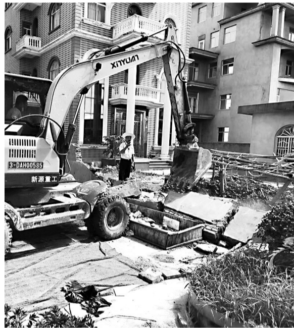
江镜镇南宵村的违建围墙被拆除
