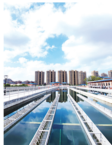
飞凤山水厂絮凝沉淀池
