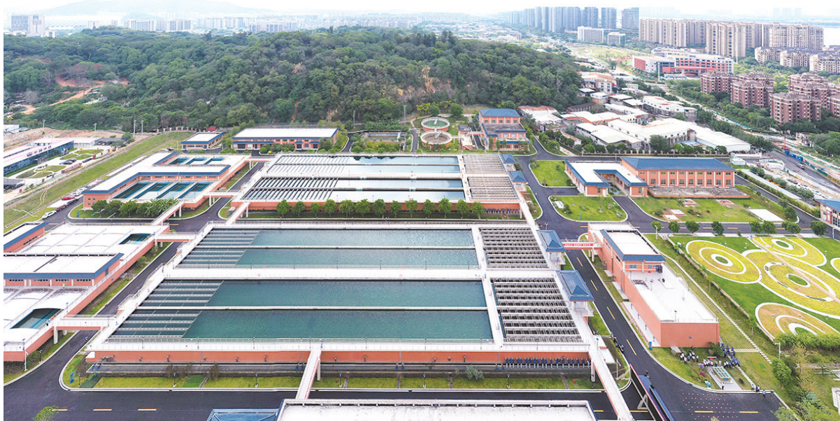
飞凤山水厂扩建及深度处理工程正式并网通水
