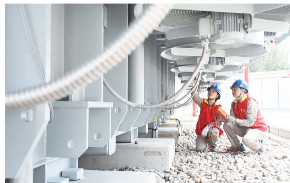
国网福州供电公司验收人员进场验收
