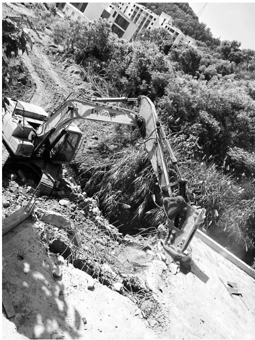
一栋违建房被强制拆除
