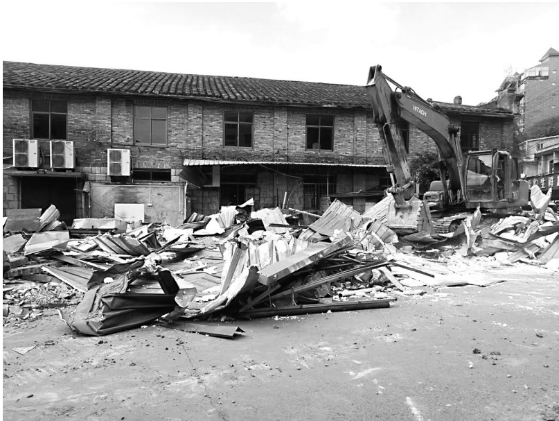
一处违建铁皮屋被当场拆除
