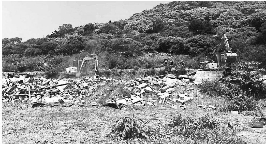
拆除一处违建房屋
