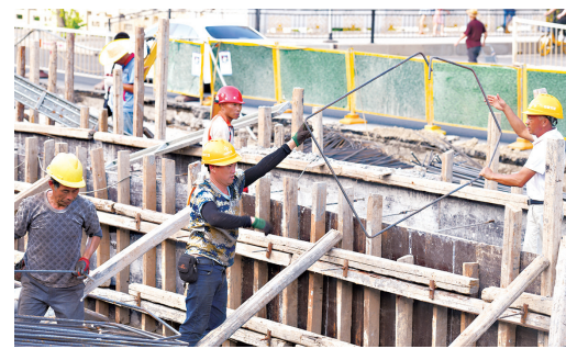
工业路(上浦路—杨桥路)提升改造工程工地现场
