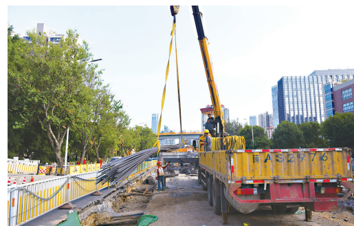
工业路(上浦路—杨桥路)提升改造工程工地正在吊装钢梁
