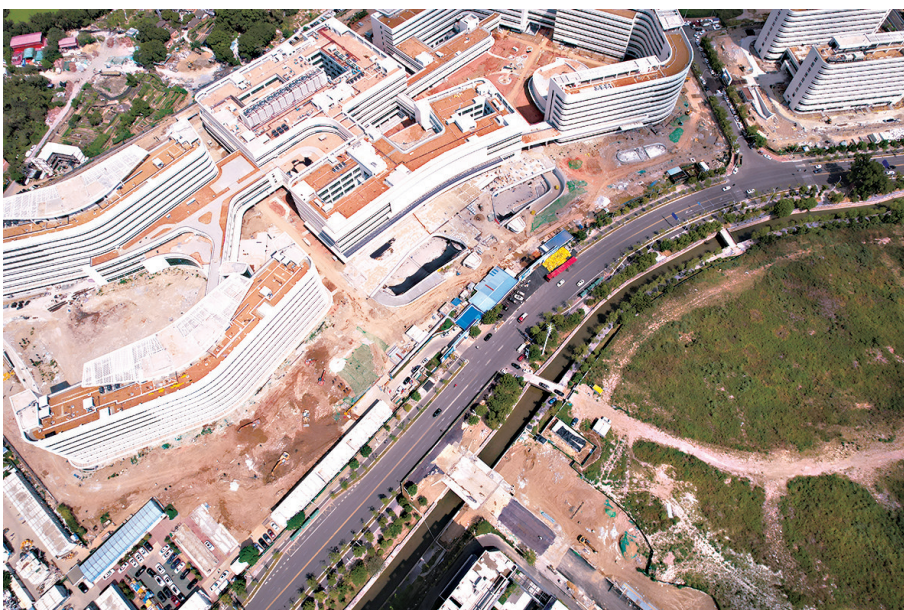
孟超肝胆医院施工现场侧向航拍图
