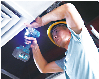
工人正在安装风口
