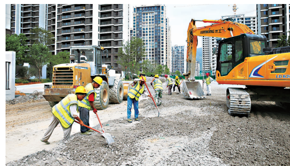
省拖片区及周边地块旧屋区道路工程工地国庆假期不休息
