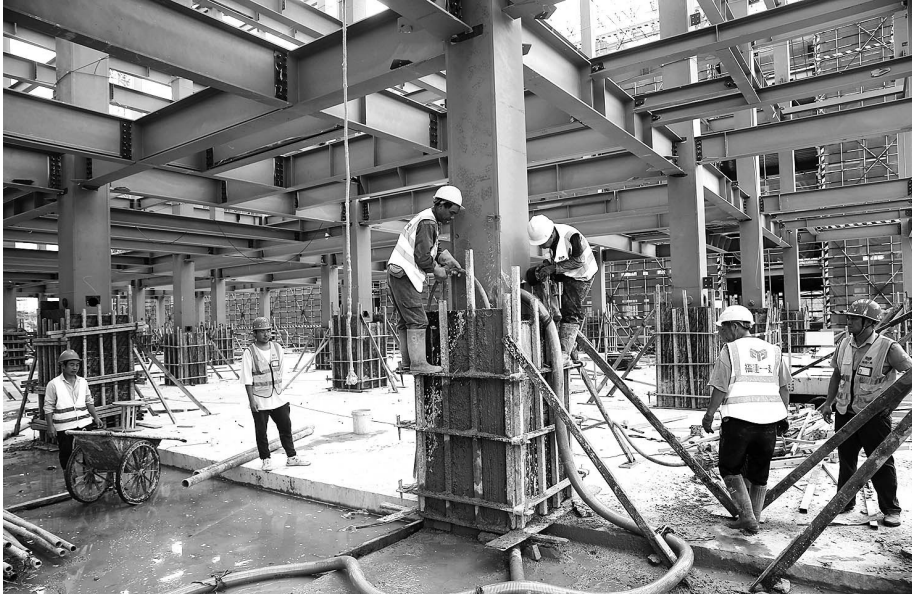
福州市中医院五四北院区项目医技楼正在如火如荼施工
