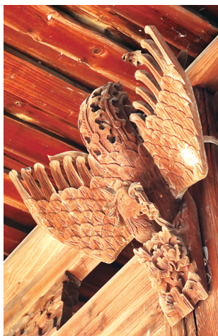
积善堂内的窗棂、梁、拱、斗等木构件,雕工繁复精美
