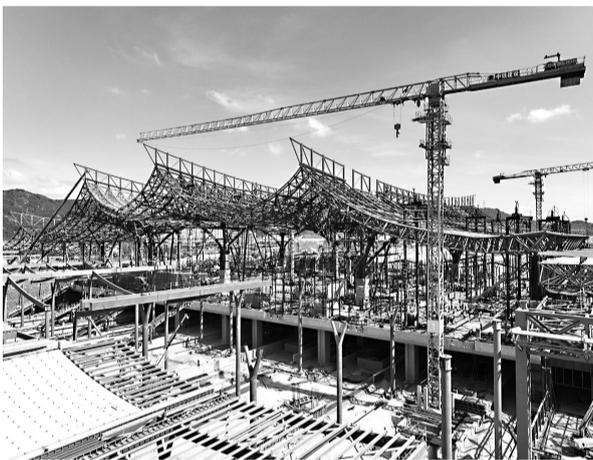
新建福厦铁路厦门北站主站房钢屋盖施工完成
