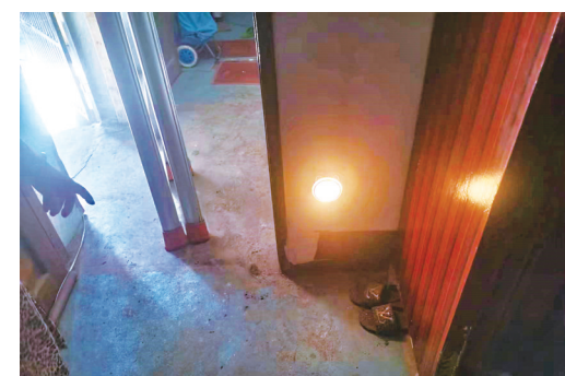
墙角安装感应式照明灯,方便老人夜间如厕
