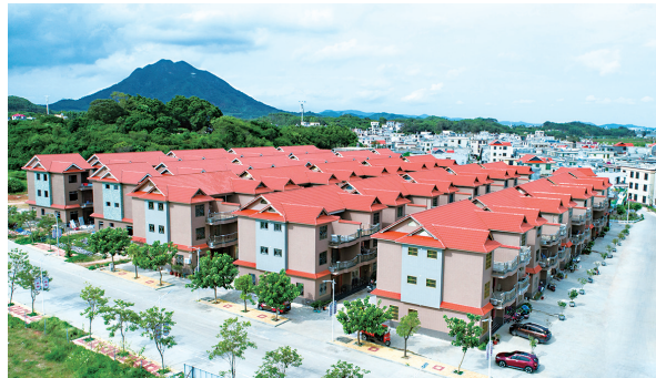
西梧村新型农村住宅小区
